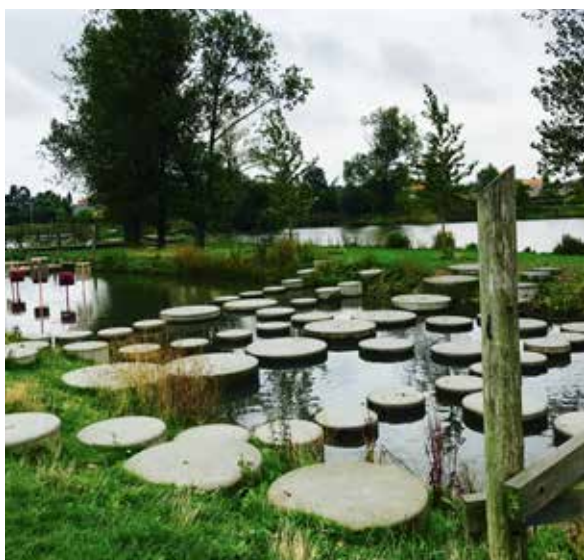
Kombineret regnvandsbassin og legeplads, Høje Taastrup
